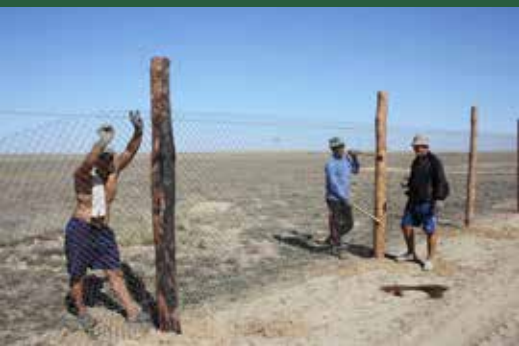
Строительство вольеров на территории Государственного природного резервата «Алтын Дала» (Костанайская область)
