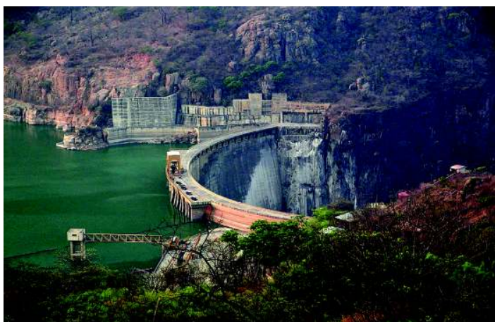
Рисунок 5.23. Плотина Кахора Басса в основном русле реки Замбези, Мозамбик. После окончания строительства плотины в 1975 году 85% вод реки Замбези стали регулироваться; эта и другие плотины бассейна Замбези оказывают значительное влияние на природное функционирование речного бассейна. В частности, Кахора Басса привела к значительным изменениям в дельте Замбези (source: Carlos Bento).
