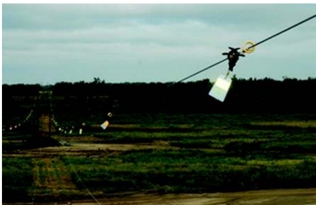
Рисунок 7.7. Сигналы (маркеры) на проводах могут уменьшить столкновения птиц с ними до 90% (источник: Altalink)
